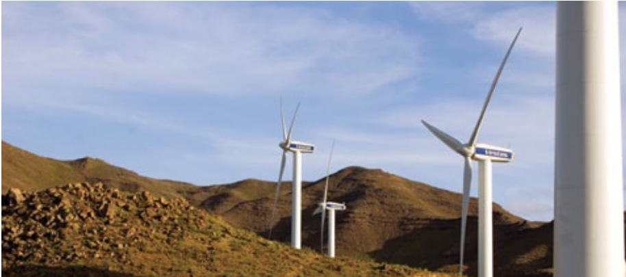
Parque Eólico da Cabeolica, São Vicente, Cabo Verde
