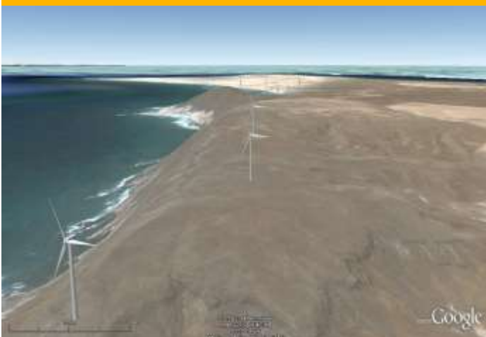
Sal, Parque eólico de Serra Negra Potência: 6,0 MW Energia: 18,0 GWh
