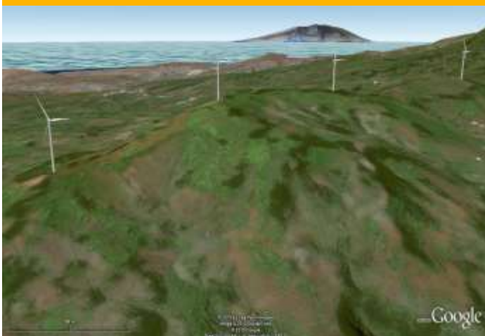
Santiago, Parque eólico de Monte Leão Potência: 3,4 MW Energia: 13,6 GWh
