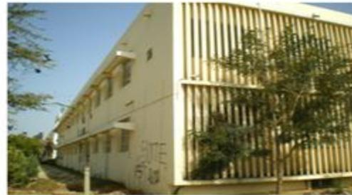
Dispositif de protection solaire vertical mobile
