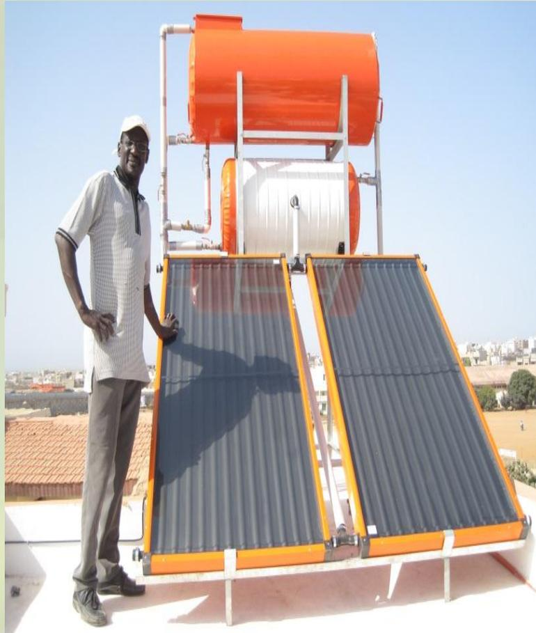
Capteur thermique : 3,3 m<sup>2</sup>
